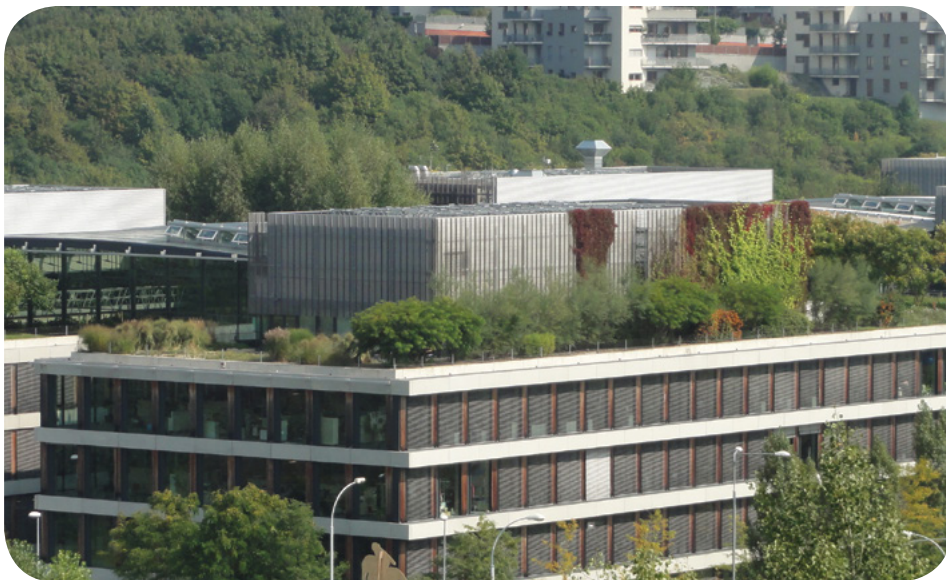
Obr. 25: Intenzivní zelená střecha a vegetační zastínění a další úsporná zařízení na budově ČSOB Radlická / Zdroj: http://www.csob.cz
