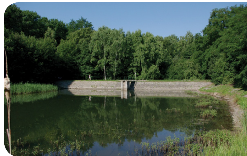
Retenční nádrž Údolní na branickém potoce / Zdroj: praha-priroda.cz
